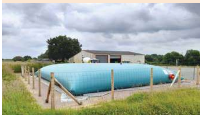
Une des 8 réserves incendies installées à Cirières
